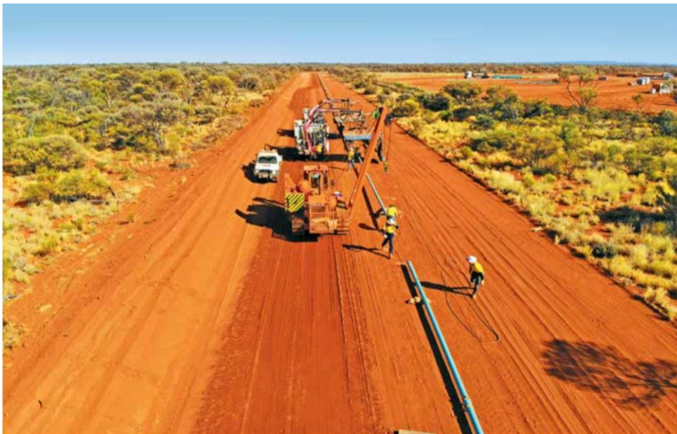
Pracownicy Nacap nadzorują badania NDT rurociągu YGP
